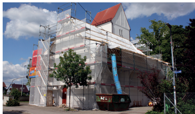
Im Zuge der Renovation wurde der Dachstuhl erneuert. Foto: Rehbein
