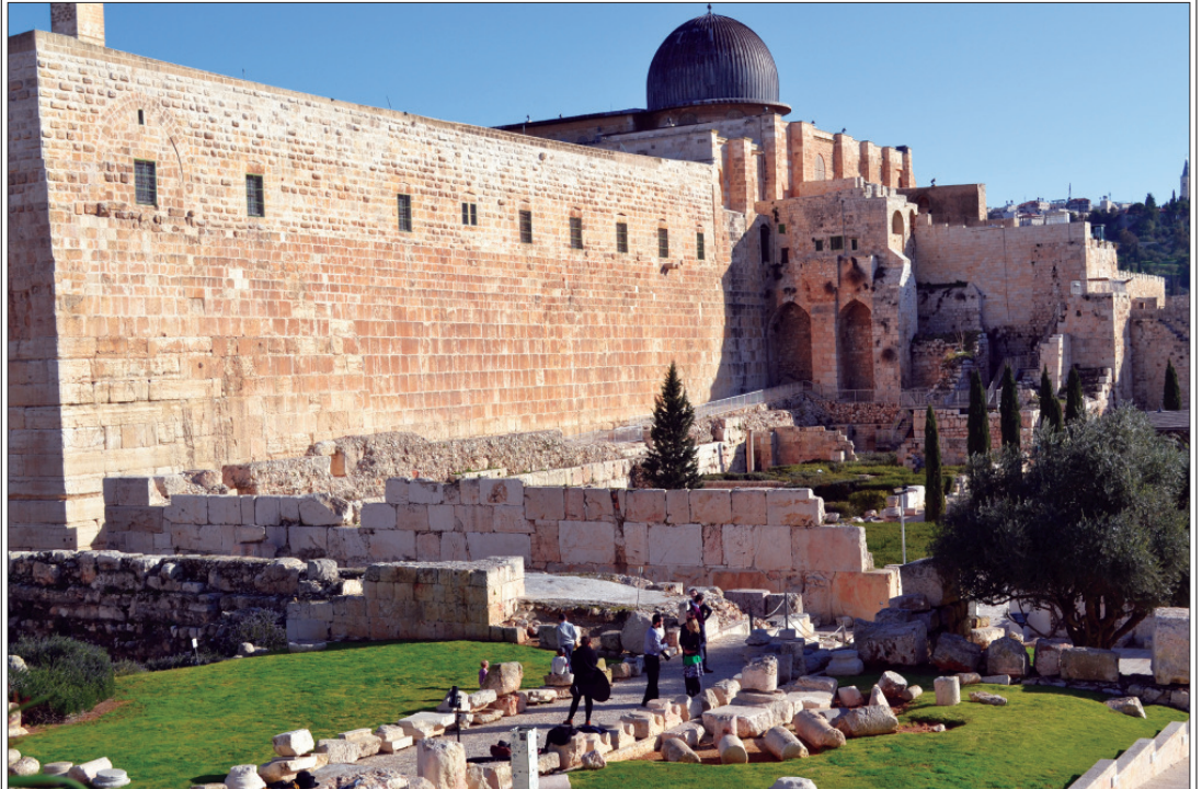
Tempelberg Jerusalem – im unteren Teil der Befestigungsmauer Steine des alten jüdischen Tempels; oben die Kuppel der Al-Aqsa-Moschee Foto: Josef Bösch
